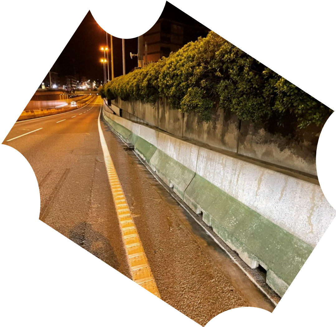
Estado final de las obras
