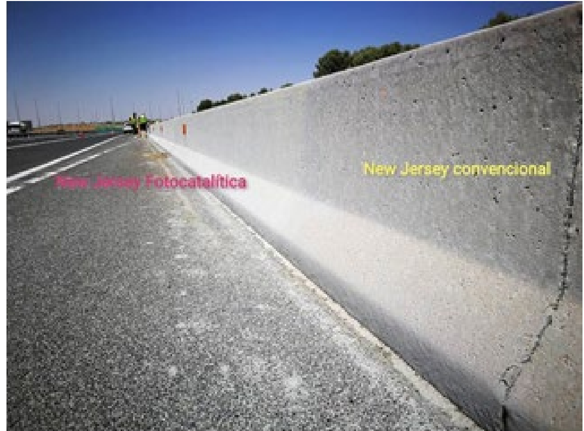
New Jersey fotocatalítica: Aplicación y estado final
