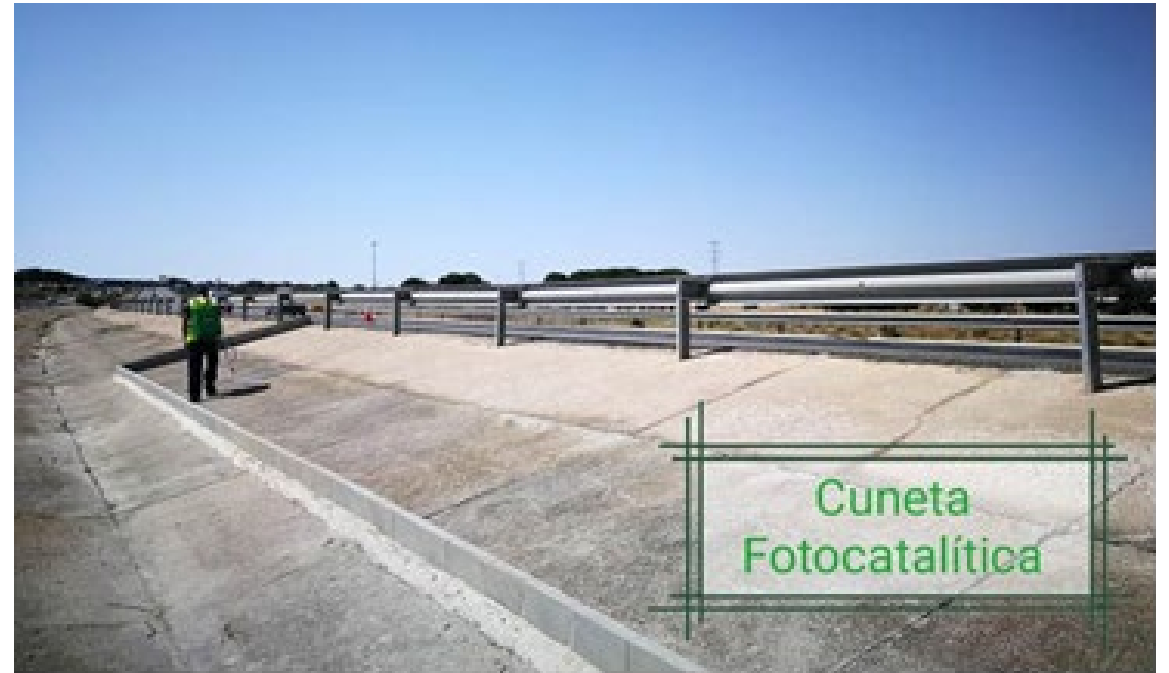
Cuneta fotocatalítica con incorporación de muestras-testigo en el hormigón
