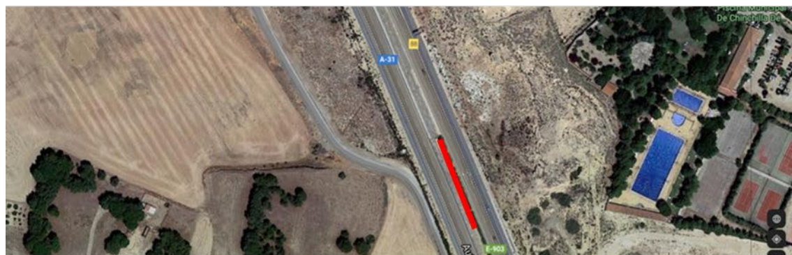
Imagen 3. Parada 2. PK 89 A-31, vista cenital de la zona de aplicación (cuneta de mediana-marcada en rojo)
