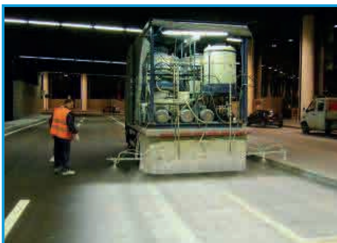
Figura 79: Aplicación de micro-emulsión fotocatalítica, mediante el prototipo patentado por "Impresa Bacchi", en la Terminal 1 del Aeropuerto de Malpensa (Milán).
