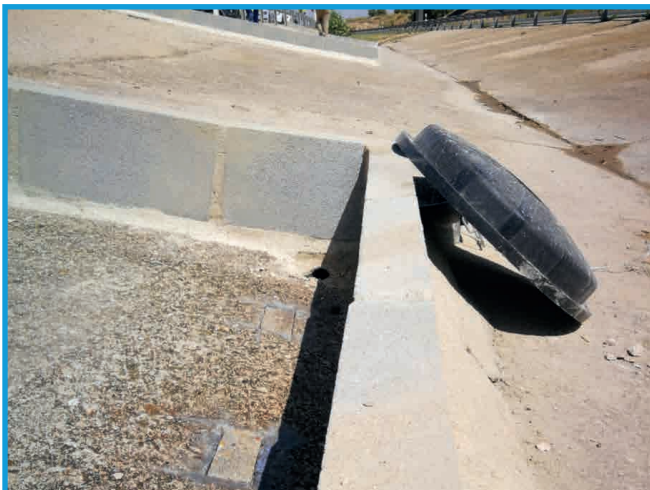
Figura 51: Ejemplo de muestras embebidas en la superficie de tratamiento fotocatalítico (en este caso una cuneta), para posterior seguimiento en laboratorio, por métodos normalizados. Fuente: AIF.
