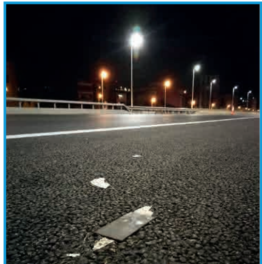
Figura 73: Detalle de instalación de muestras testigo en arcén, antes del comienzo de los trabajos de tratamiento fotocatalítico. Fuente: Eptisa.
