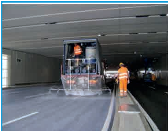
Figura 20: Proceso de pulverización de spray fotocatalítico sobre pavimento existente (Izda.). Detalle de acabado de extendido de spray fotocatalítico en aceras en Milán (Dcha.). Fuente: Empresa Bacchi.
