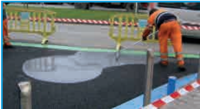
Figura 14: Proceso de extendido y percolación de lechada fotocatalítica sobre un pavimento drenante. Fuente: Eurovía.
