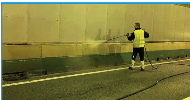
Figura 93: Limpieza previa de la superficie de aplicación. Fuente: Eptisa.
