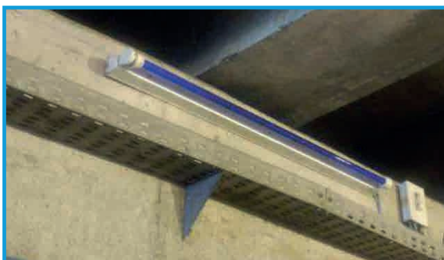
Figura 97: Cambio de luminarias existentes a LED, para activación del fotocatalizador, en el túnel del El Espinillo. Fuente: Ayuntamiento de Madrid.
