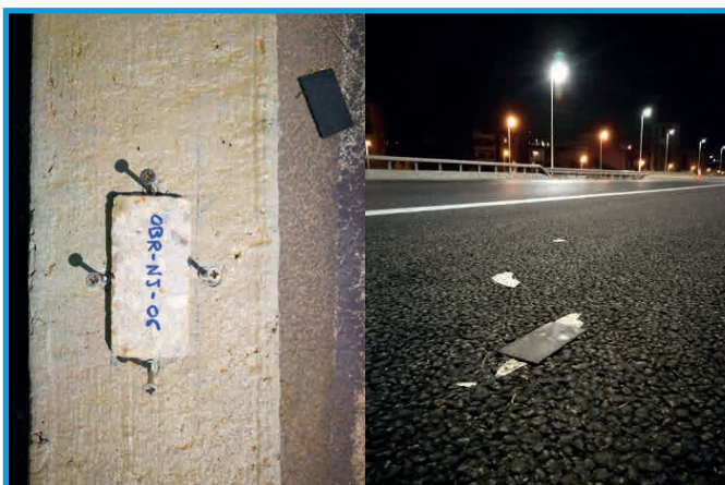
Figura 7.A: Colocación de muestras testigo sobre New Jersey de Autovía de Los Llanos (Izda.) y arcén de Autopista C-31 (Dcha.). Fuente: Eptisa.
