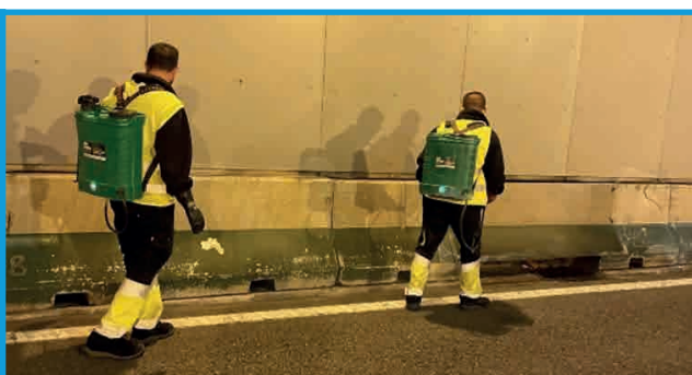
Figura 94: Aplicación de tratamiento fotocatalítico sobre elemento de contención. Fuente: Eptisa.
