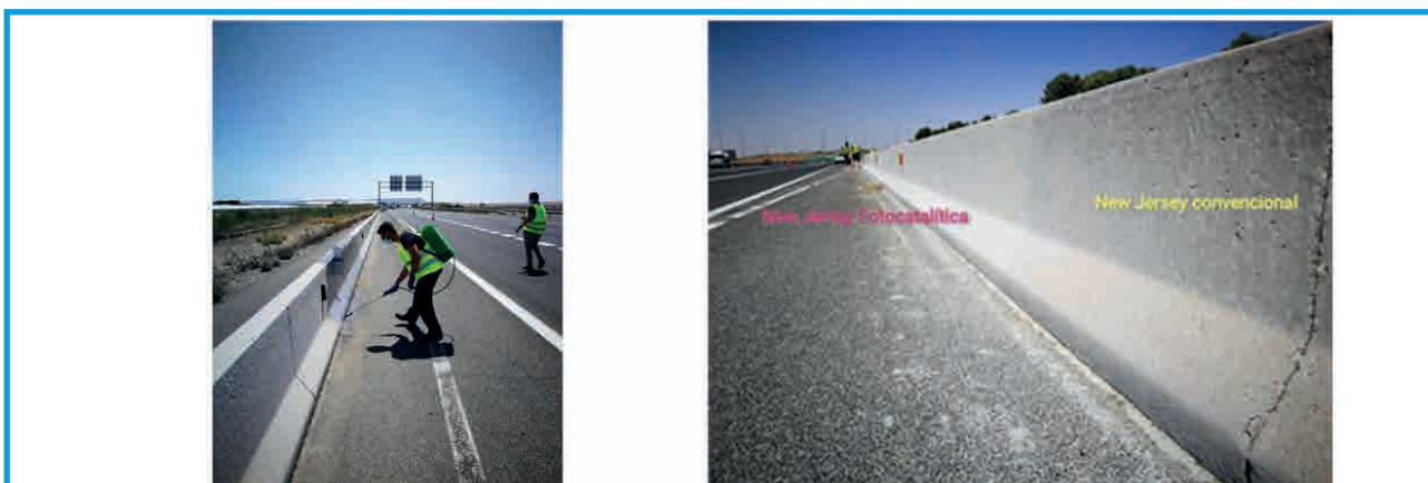
Figura 88: New Jersey fotocatalítica: Aplicación y estado final. Fuente AIF.
