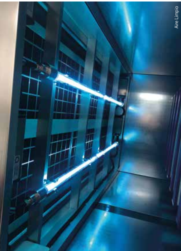
El objetivo del proyecto liderado por Aire Limpio es destruir en minutos el SARS-CoV-2 suspendido en el aire interior, sirviéndose de un sistema fotocatalítico eficiente.
